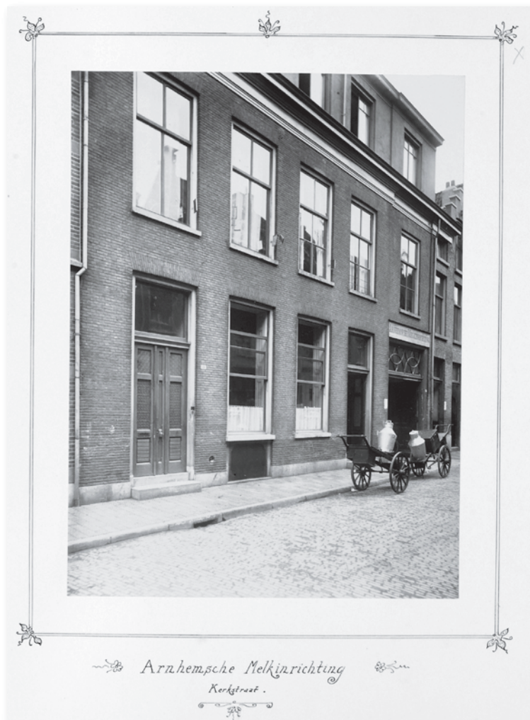
Het gebouw van de eerste Arnhemse Melkinrigting in het gedenkboek van het brandwezen, eind 19e eeuw. (Gelders Archief 1523 - 64-0045)
